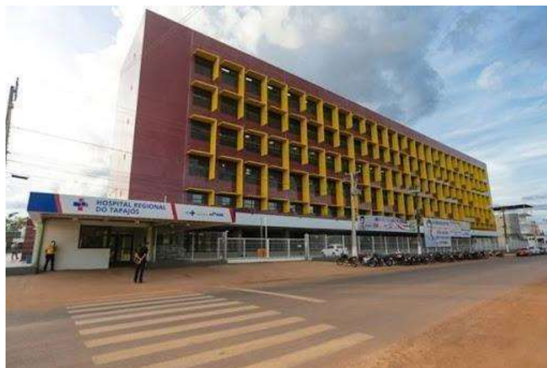
Imagem do Hospital Regional do Tapajós no município de Itaituba - Acervo Isco
